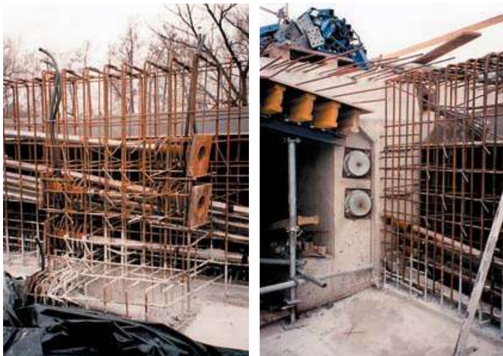
Rysunek 3.33. Łączenie kabli na zakład: po lewej – układ zbrojenia miękkiego, po prawej – widok po zabetonowaniu (fot. Jan Biliszczuk)
